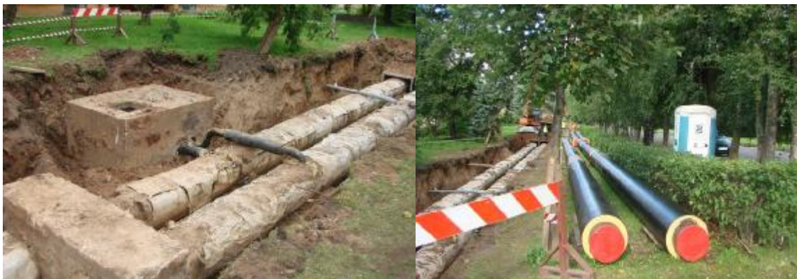
6. att. Salaspils pilsētā nomainītās vecās siltumtrašu caurules ar jaunām rūpnieciski izolētām siltumtrašu caurulēm
