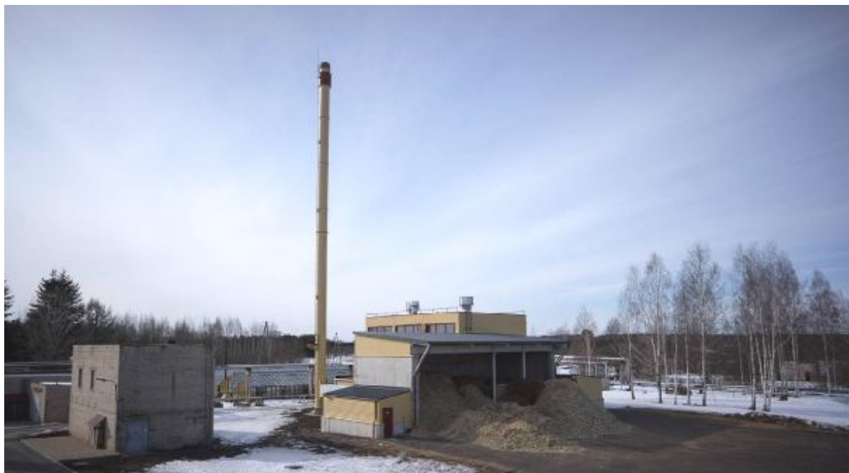
5. att. Jaunā šķeldas katlu māja
